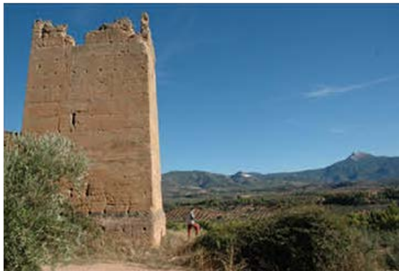
TORRE DEL CARDETE (BENATAE)
