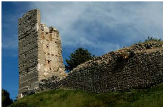
TORRE DE GÓNTAR (SEGURA DE LA SIERRA)
