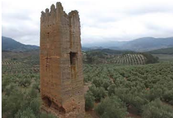
TORRE SUR DE SANTA CATALINA (ORCERA)
