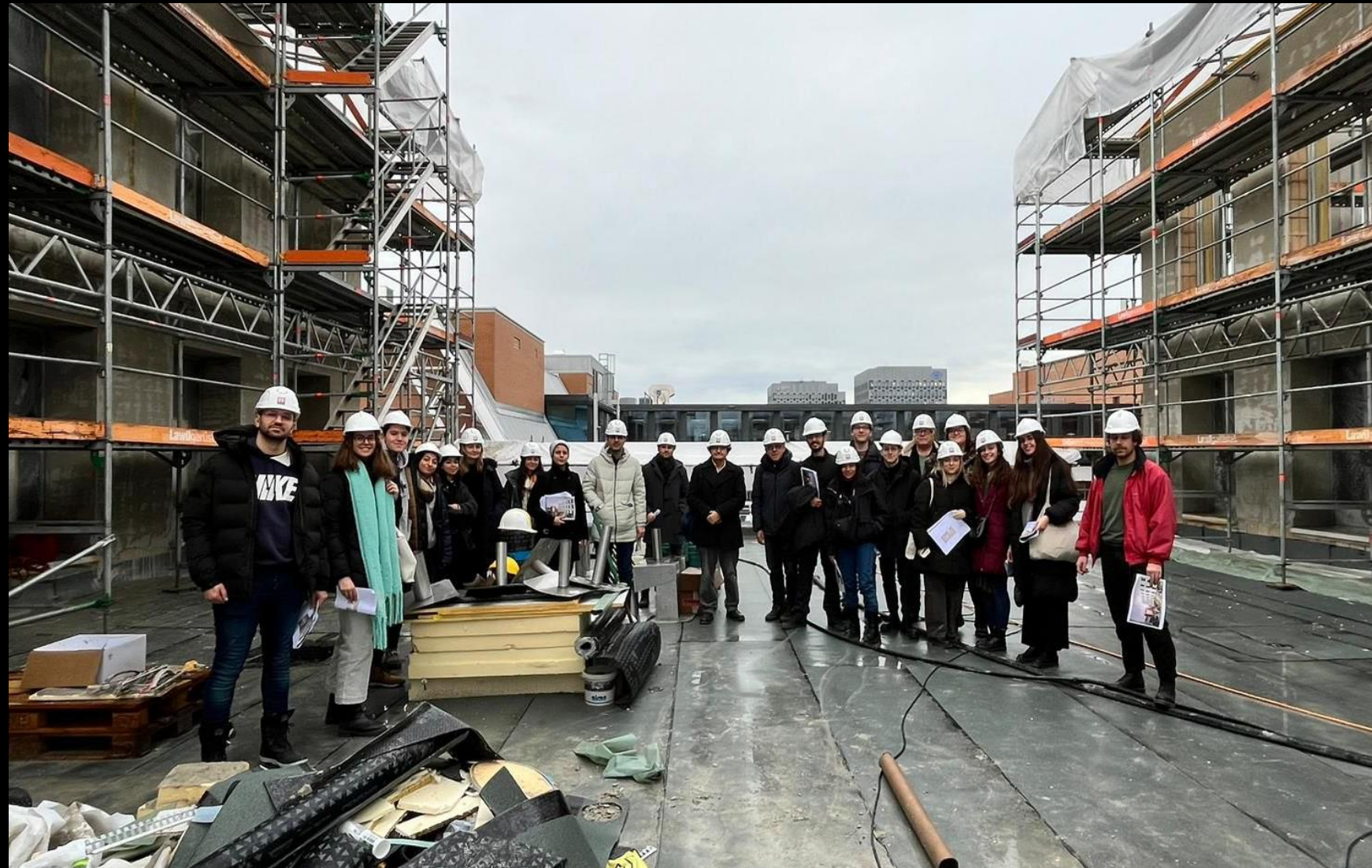
Visita de obra guiada. Edificio JED 2226 en Zürich. Baumschlager+Eberle Viaje de estudios a Suiza: Curso 23/24
