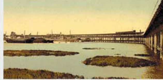
Embarcadero de Río Tinto Company Ltd. en Huelva
