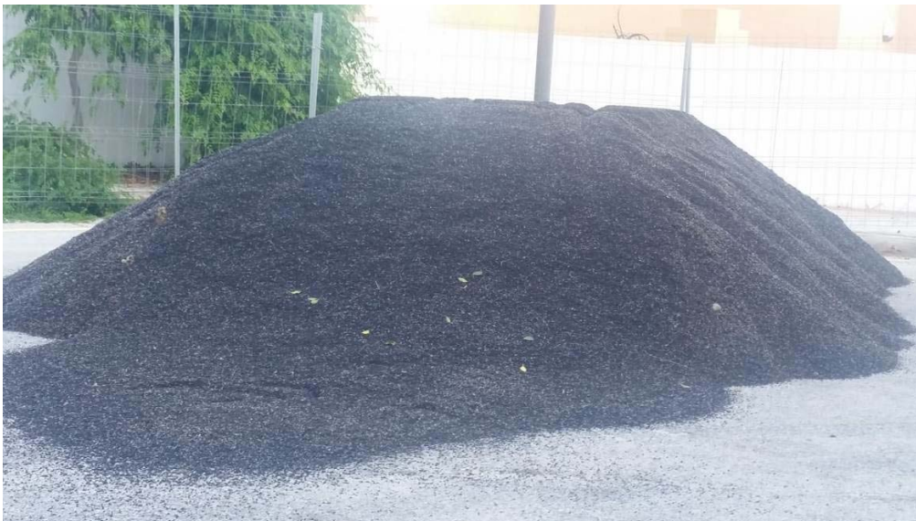
Acopio en la urbanización del material de reciclado para el relleno
