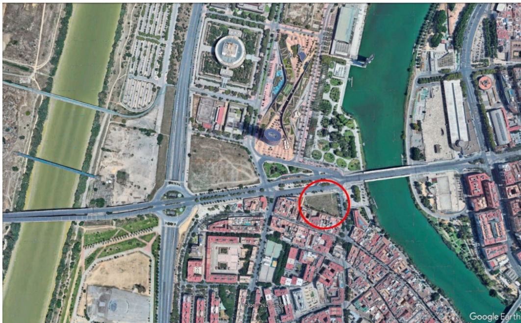
Ortofoto del emplazamiento (Sevilla). Fuente: Google Earth
